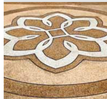
construction - restauration Konstruktion Restaurierung
